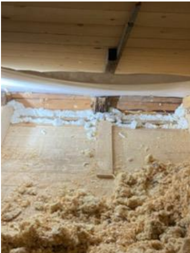
Värmeläckage upp mot vind är tätat men bör hållas under uppsikt under januari till mars för att säkerställa önskad effekt.
