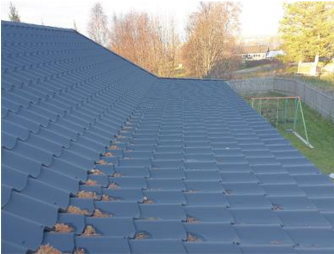
Del av yttertak är låglutande.
